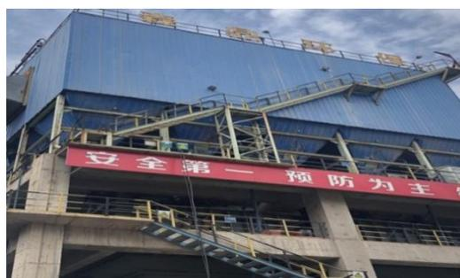
图 6 年处理 100 万吨热泼钢渣破碎磁选分选线
